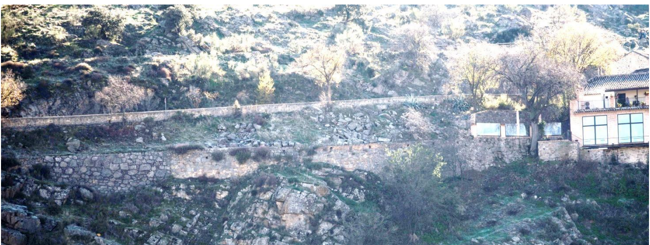
Visión desde la otra orilla del Tajo del perfil de la carretera y del muro inferior de mampostería (la ermita a la derecha)
